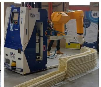
**3** pays de la Loire **Nantes, la construction d'une maison de 95 m<sup>2</sup> grâce à une imprimante 3D et un robot.**
