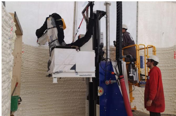
Cette matière a plusieurs intérêts : son faible coût, sa durabilité et ses excellentes propriétés mécaniques. Ensuite, cette sorte de chantilly forme deux parois entre lesquelles est coulé le béton nécessaire pour la structure. La difficulté tient dans la pression hydrostatique : le polyuréthane va permettre au béton de prendre facilement.
