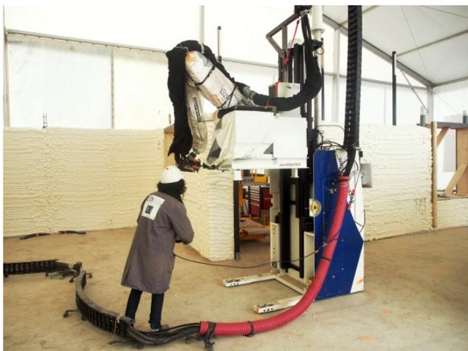
«Elle imprime en 3D des banches creuses en mousse polymère au sein desquelles est coulé du béton »
